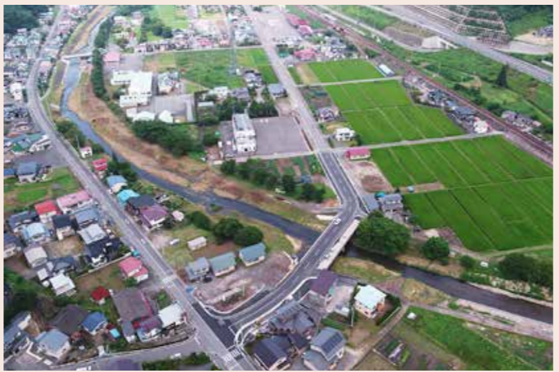
沢山橋の改良工事が完了(7月)
