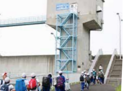
水門の階段を上り、その大きさを確認
