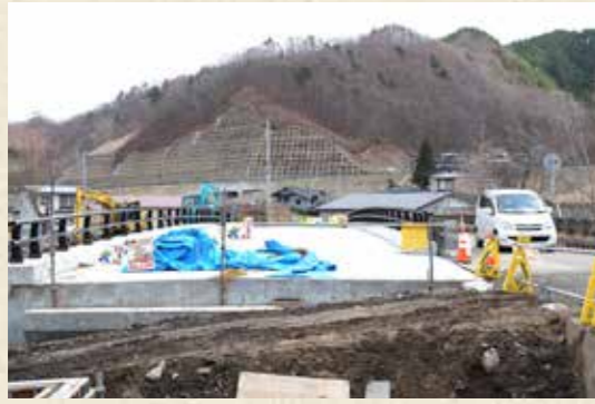
村道や各橋梁などの老朽化対応を施します (工事が進む沢山橋)
