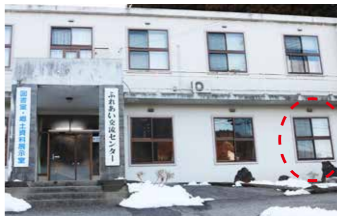
2月から交流センターの一部を改装し始めました
