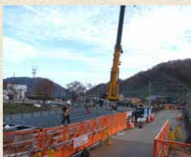
工事が進む新沢山橋
