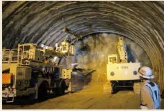
三沿道の工事が促進されるよう連携した取り組みを行います
