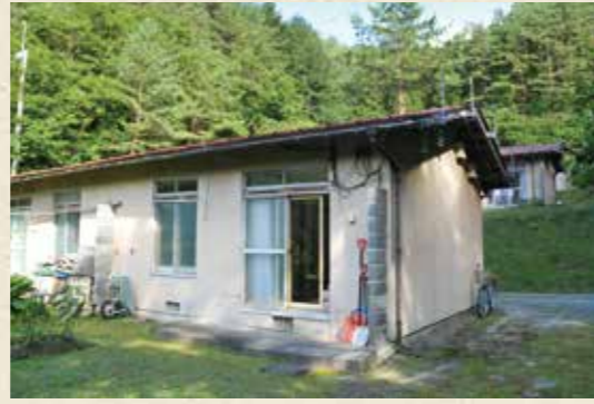
村営住宅の長寿命化改修などを行います(村営南浜住宅)
