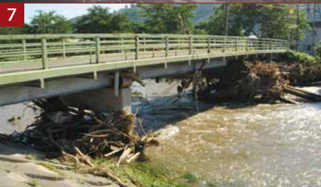
1, 旭日区の道路は冠水し通行止め 2, 元村地区の断水に伴い、給水車が出動 3, 暴風による倒木も村内各地で発生 4, 配水池へとつながる水管橋の流出が断水の原因だ 5, 床上浸水した高齢者活動施設。前日までふだいまつりの太鼓の練習で村内に太鼓の音が響いていた 6, 村内各地で通行止めが発生 7, 羅賀橋は河川の増水により、中央の橋脚が流出。それ以外の橋脚に堆積した流木が氾濫を引き起こしたと考えられている
