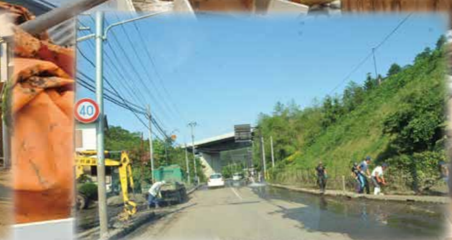
村消防団による必死の復旧作業が行われた
