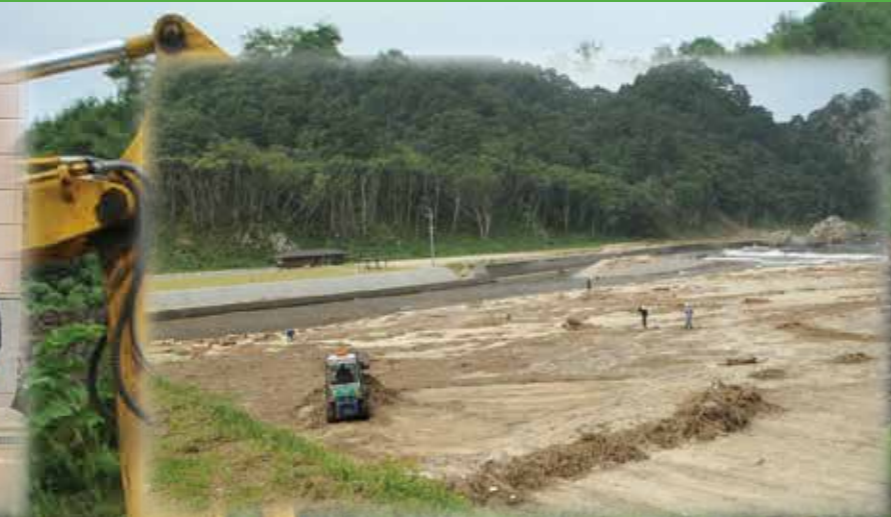
村内外の建設業者による必死の復旧作業
