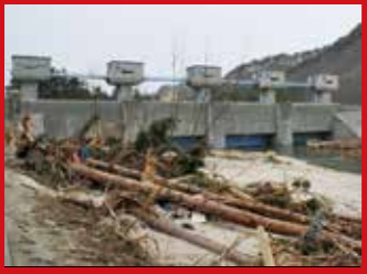
元村地区を守った普代水門
