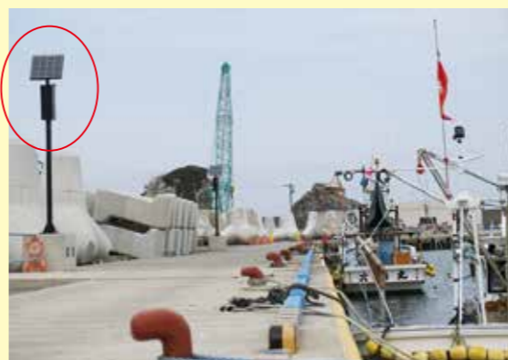
新港に4基の防犯灯が設置されています
