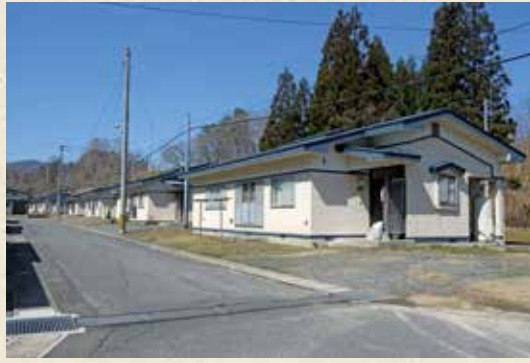
村営住宅などの生活環境整備を行います (芦渡地区住宅)
