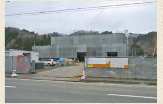
防災計画などに基づき防災力の強化に努めます(建設が進む新消防分署)
