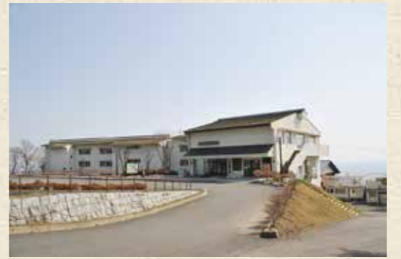
「くろさき荘」は繰越しとなった食堂兼厨房棟の早期完成に努めます
