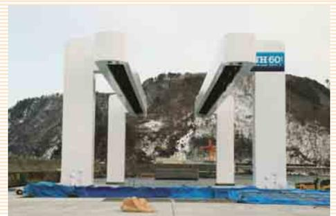
漁船修理のための上架施設で、3月末には完成予定。震災前はウインチ方式で、一隻ずつしか修理出来ませんでしたが、現在建設中のドックはクレーン方式で、一度に複数の船が修理可能です。
