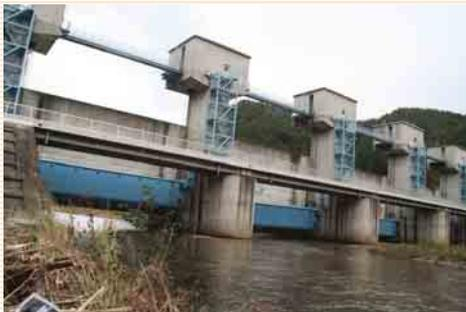
東日本大震災の大津波は水門を超え、上流側に設けた橋を破壊しましたが、約200m上流で止まりました。平成25年3月には、管理橋の架け替えや地盤沈下によるかさ上げ工事が完了しています。
