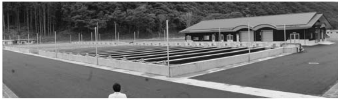
田野畑村明戸地区に完成したサケふ化場。稚魚池は1,050平方メートルを2池整備しました
