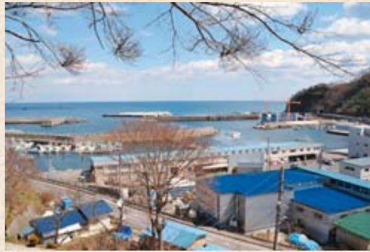
沖防波堤の工事を継続する太田名部漁港。加工用水の整備も行います
