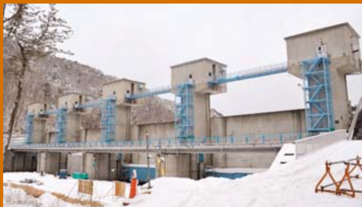
今年3月の完成を目指す普代水門。取付道路も手すりが付き完成。電気系統の工事を残すのみ
