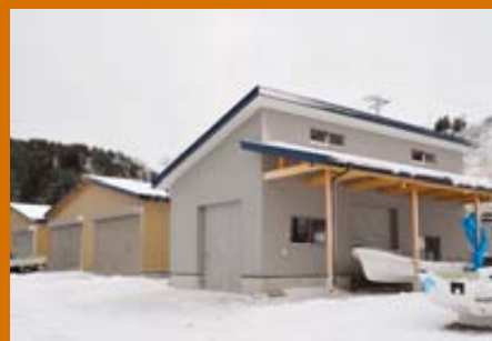
堀内漁港では、村の補助金を活用し、新しい作業場が数軒建設されました
