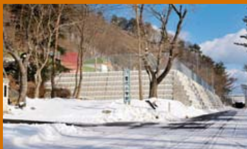
普代水門裏の普代小は、少しでも危険度を軽減するため校庭を4畝かさ上げ。海拔は約10畝に
