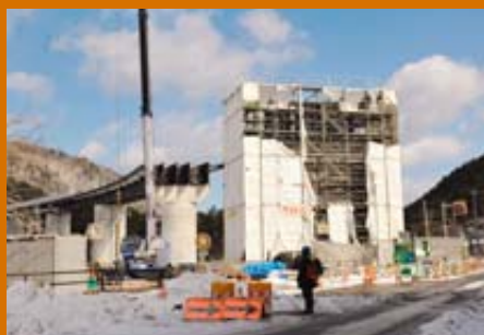
最後の橋脚の工事が急ピッチで進む普代バイパス。まもなくつながります
