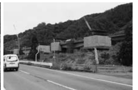
橋脚の工事が進む深渡橋付近
