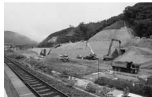
山が削られ道路の形が見えてきた普代駅裏付近
