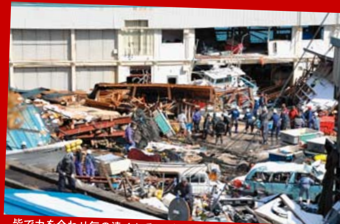
皆で力を合わせ気の遠くなるほどのがれきを撤去(太田名部市場)
