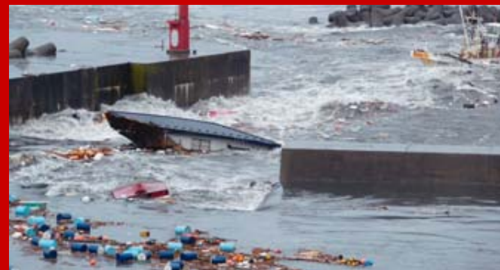
引き波が家の屋根までさらっていきます(堀内漁港)
