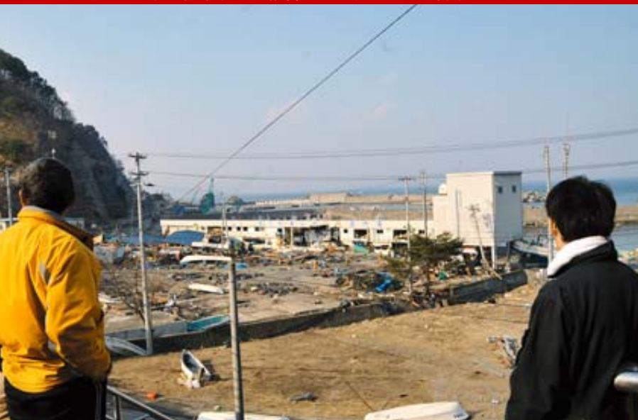
太田名部防潮堤から被害を見る漁師たち。言葉もない
