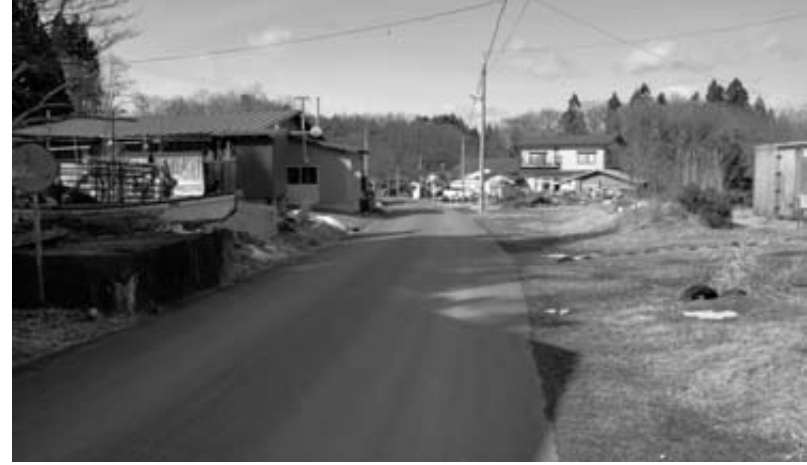
排水溝などの整備が望まれる村道(白井地区)
