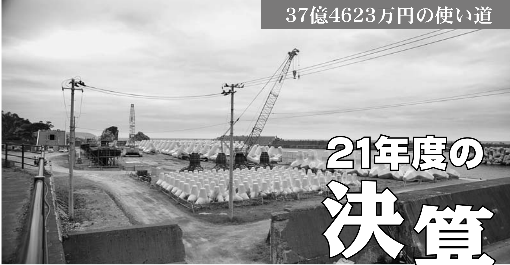
テトラポットが並べられ、工事が進む太田南部新港
