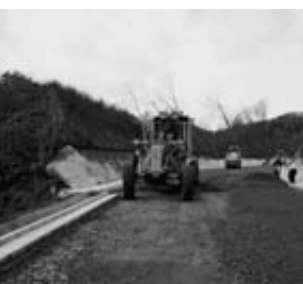
工事が行われている下閉伊北区域農用地の広域農道(萩牛地内)
