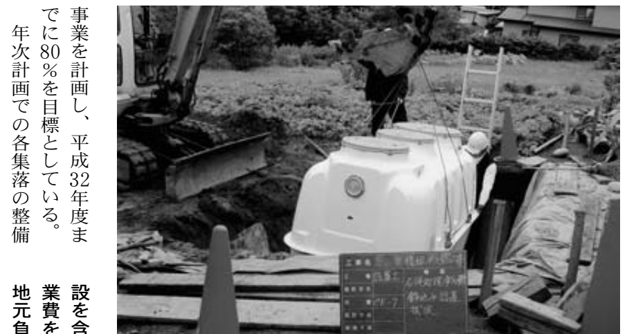
一般家庭への合併処理浄化槽の設置工事
