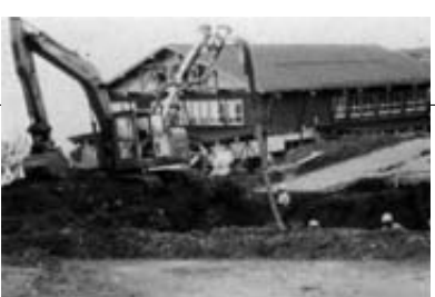
昭和55年の大規模改修工事
