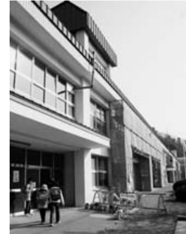
平成22年4月の統合を控え普代小学校耐震工事などが進む
