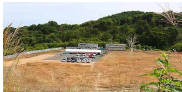
いよいよ工事が始まる白井地区の建設予定地
