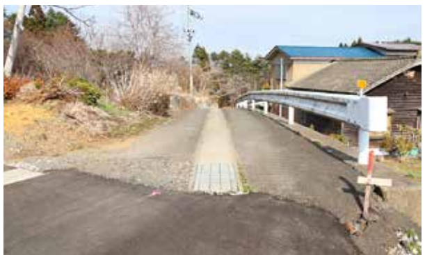
道路の舗装・側溝等補改修や改良工事を進めます （写真は黒崎3号線）
