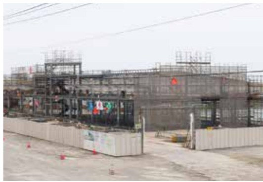
新魚市場整備事業を推進します(写真は建設中の新魚市場)
