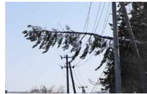
暴風雪により木が倒れ、電線にもたれかかる
