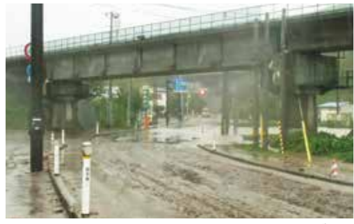
台風19号災害で冠水した普代インターチェンジ付近
