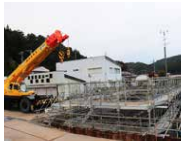
浸水対策ポンプ設置工事 (7,366万円)
