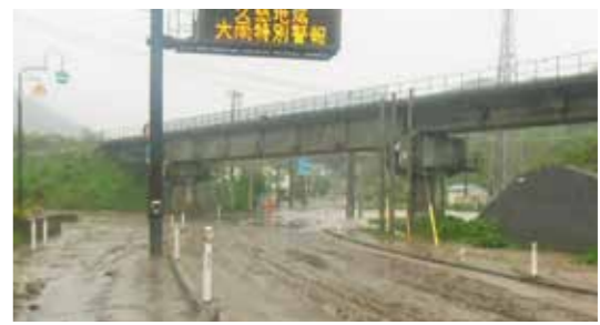
台風災害で冠水し、通行不能となった普代インターチェンジ付近
