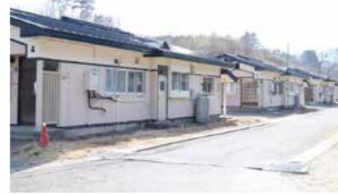
村営住宅の修繕やリフォーム助成を行います（芦渡住宅）
