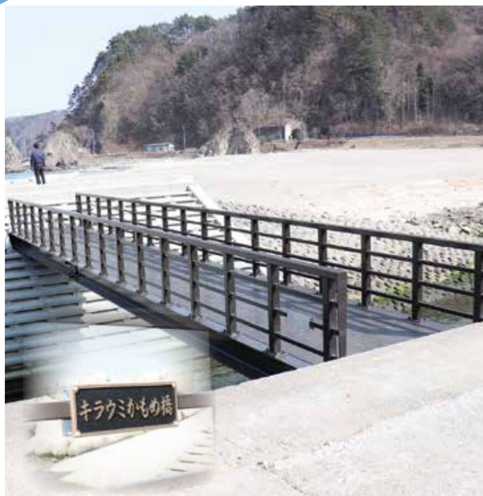
「キラウミかもめ橋」が完成しました
