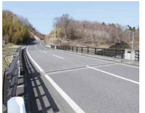
道路維持整備や橋りょうの長寿命化を図ります
