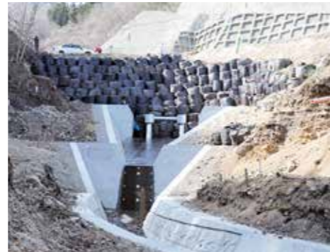
復旧事業を完遂させ、災害に強い村づくりの推進に努めます（普代の沢砂防堰堤工事）
