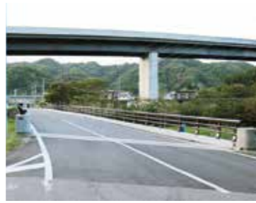
橋りょう長寿命化修繕事業(1億4,382万円)
