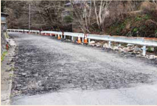
台風災害復旧工事に加え、村道や橋りょうなどの老朽化工事を施します（村道沢港線）
