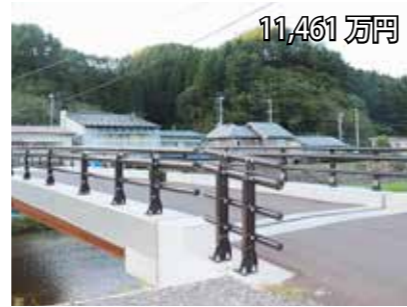
11,461万円 台風10号災害復旧事業 (道路・橋梁の復旧工事を実施)
