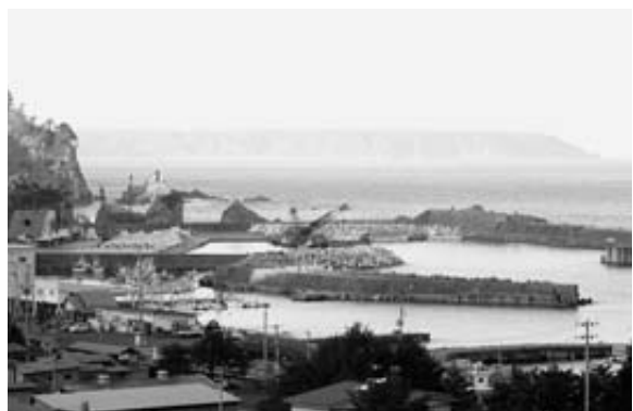
着々と工事が進む太田名部新港。全体的な活用策の検討が望まれています
