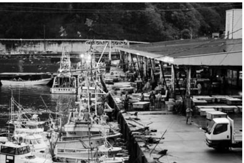
秋サケ漁で賑わう太田名部漁港。新港の建設に伴い、新しい荷捌き施設の建設が望まれています
