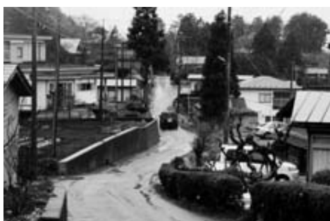
改良が望まれる堀内中央道
