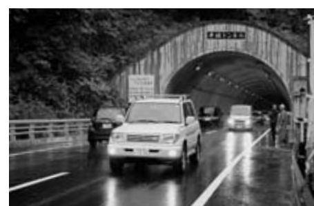
10月8日に開通した早坂トンネル (広報いわいずみ提供)
