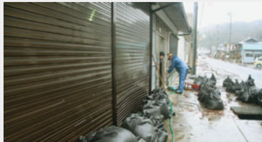
やっと冠水も収まり、ホースで泥を洗い流すなど片付けが行われました (27日、15:31)
