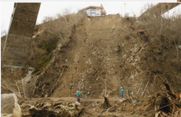
堀内大橋の南側から地滑り。土砂が沢川をふさぎ沢漁港付近は大被害に (28日、13:45)
