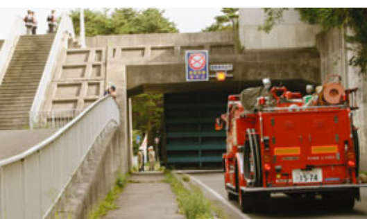
津波警報の発令を受け、普代水門を閉鎖する消防団員ら
