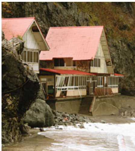
ネダリ浜レストハウスも壁や窓が破損
