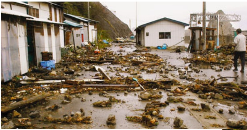
沢漁港には高波で打ち上げられた石が散乱
