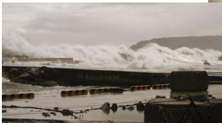
10メートルを超える高波が襲う白井漁港。 50トンのブロックが6個飛散しました
