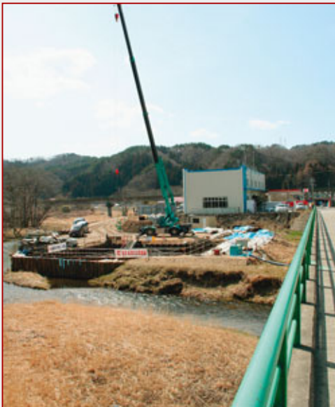
普代バイパスの橋脚工事が進む太田名部橋付近
