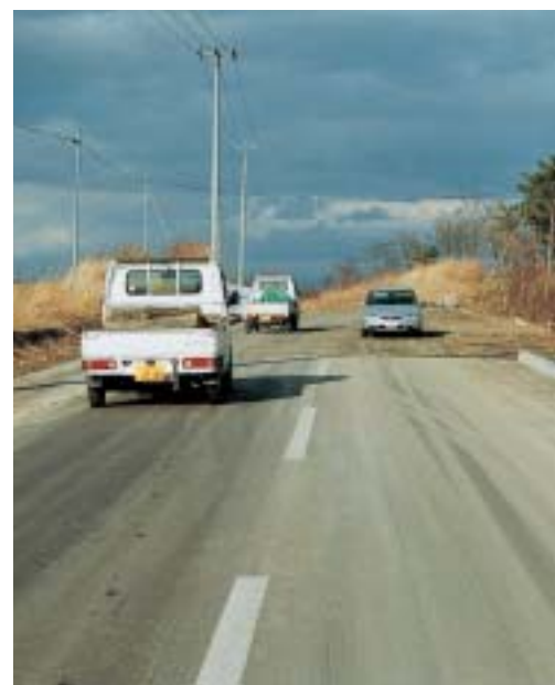
白井鳥居線道路舗装工事は本年度完成予定
