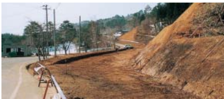
白井・鳥居、岩泉町龍泉洞間の大規模農道工事は順調に進捗
