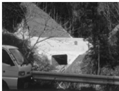
着々と進む普代バイパス工事
