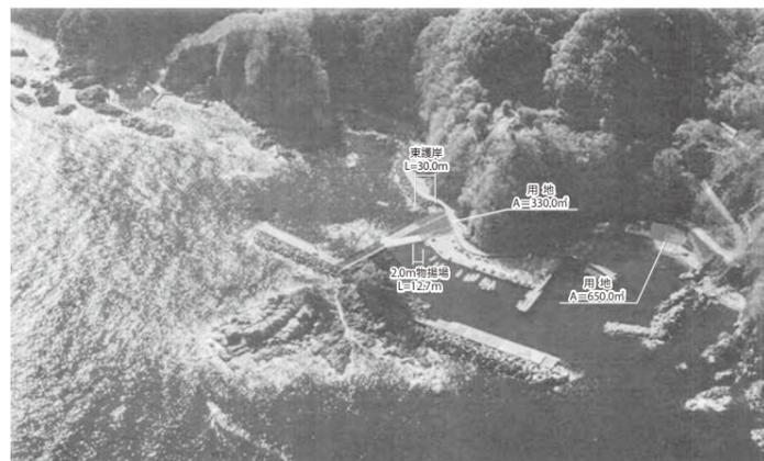
写真左の力持漁港側からの波の侵入を防ぐため、東側の護岸にテトラポットの投入や、ケーソンのかさ上げ工事などが行われています
