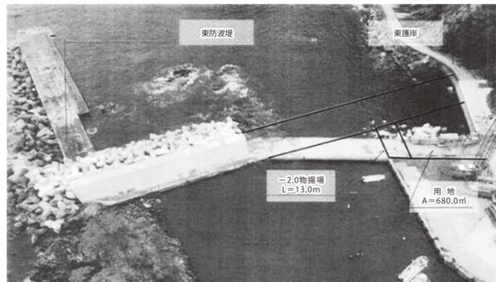
変更契約では、東防波堤の先行工事の部分から村道白井海岸線までのケーソン本体の工事、新たにできた用地の埋立などを行います
