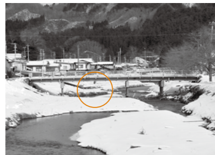
台風10号で橋梁が折れた羅賀橋
